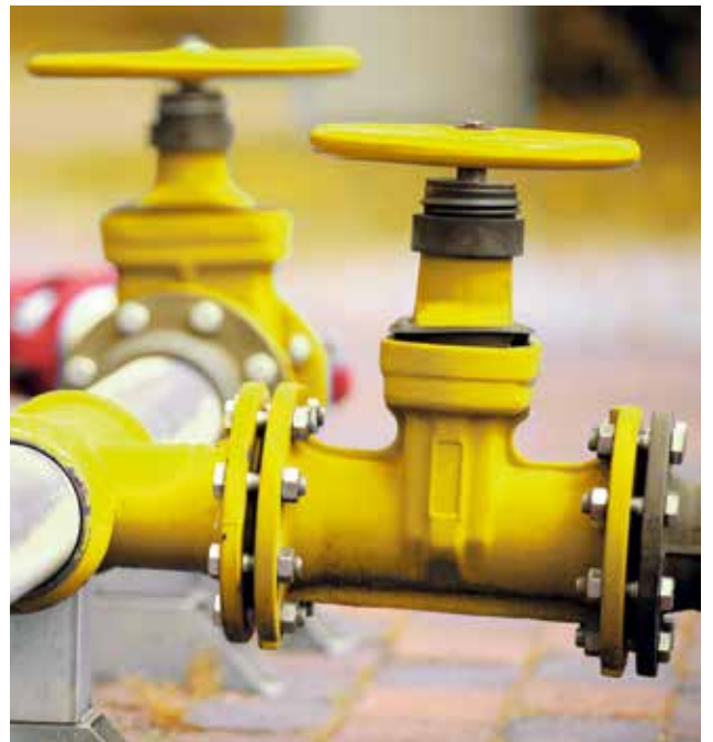
Wasserstoff soll perspektivisch im Gasnetz transportiert werden. Foto: AdobeStock, pixel-kraft
